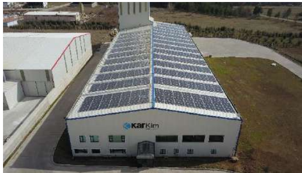
Karkim Yapı Kimyasalları - 320 kWp/240 kWe
